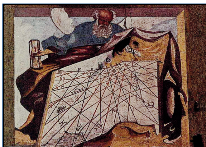
Figura n. 2: Cuornè (TO). Quadrante solare declinante ad Est con stilo obliquo (rappresentato da una falce), linee orarie francesi, linee orarie italiche, linee orarie babiloniche, linee solstiziali, linee diurne, linea equinoziale e segni dello zodiaco. Sull'equinoziale (contraddistinta dal simbolo della bilancia) le linee orarie francesi incontrano le corrispondenti linee orarie italiche posticipate di sei ore e quelle babiloniche anticipate di sei ore.
